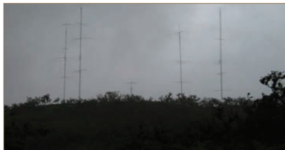
Fotos 5a y 5b: Antenas de la estación HC8N
