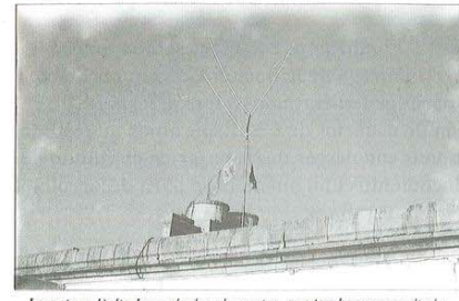
La antena Delta Loop de dos elementos, que tan buenos resultados nos proporciona en las expediciones DX.
