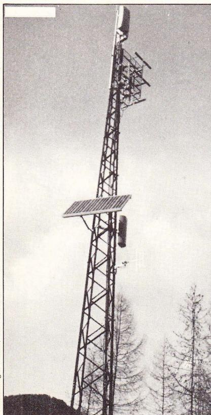
Repetidor alimentado con energía solar.
