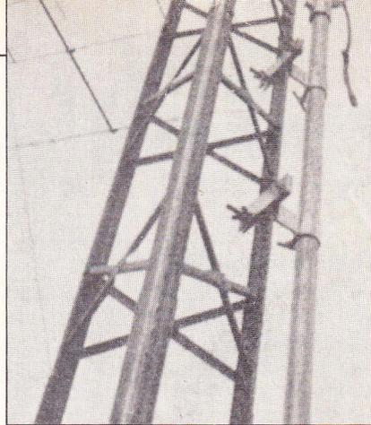
kit y comprende una polea y dos abrazaderas ajustables destinadas a una fijación robusta en una pierna de torreta, como muestra la ilustración. La distancia entre estas abrazaderas es regulable a voluntad. El precio es de alrededor de los 200 \$ USA.
