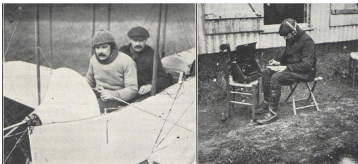
Mauricio Farman efectúa experiencias de telegrafía sin hilos a bordo de uno de sus aparatos en el aeródromo de Buc. El individuo situado detrás de Farman transmite despachos con el aparato que va instalado a bordo. A la derecha la estación receptora de Buc.
