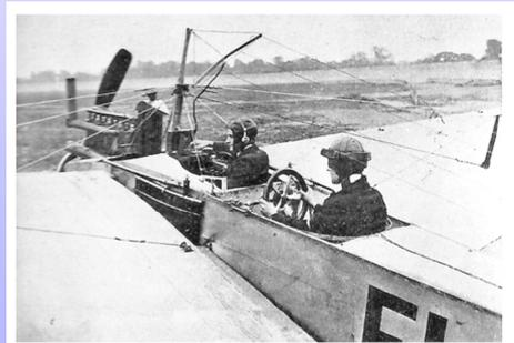
Septiembre de 1911 - Ensayos de comunicación por radio aire-tierra realizado en *Brooklands* (Inglaterra) en un monoplano biplaza *Flanders F.3* pilotado por *E. V. B. Fisher*, utilizando un transmisor radiotelegráfico portable de chispa *Marconi* alimentado con una batería de 6 voltios. Fotografía: <http://flyhistoricswinga.com/2013/05/accident-report-no-1/>
