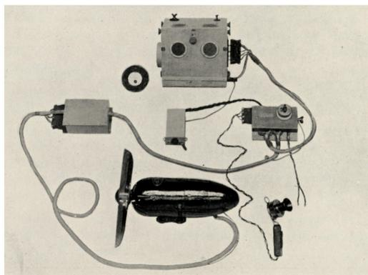
Marconi AD 1. Radiotransmisor telefónico y telegráfico
