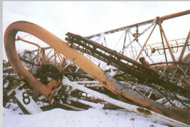
Los tubos de acero de la torre tenían un diámetro de unos 25 centímetros y una longitud de unos 5 metros. Para sostenerse, el mástil estaba sostenido en cinco niveles con 3 cables que lo anclaban al suelo. A la altura de 121, 256, 369, 481 y 594
