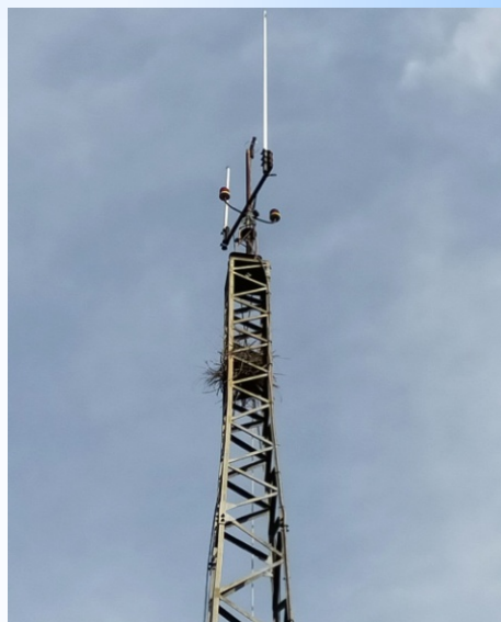
Antigua Torre de transmisiones
